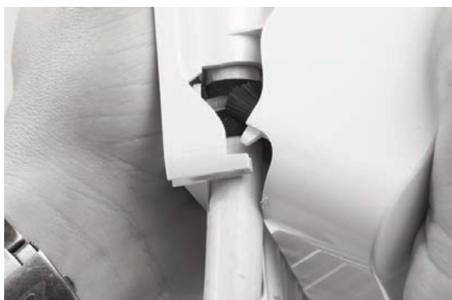
6.2 Enlever l'opercule du couvercle afin de laisser passer le câble en passage.
