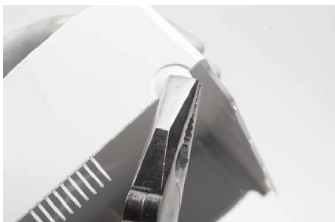
6.2 Enlever l'opercule du couvercle afin de laisser passer le câble en passage.
