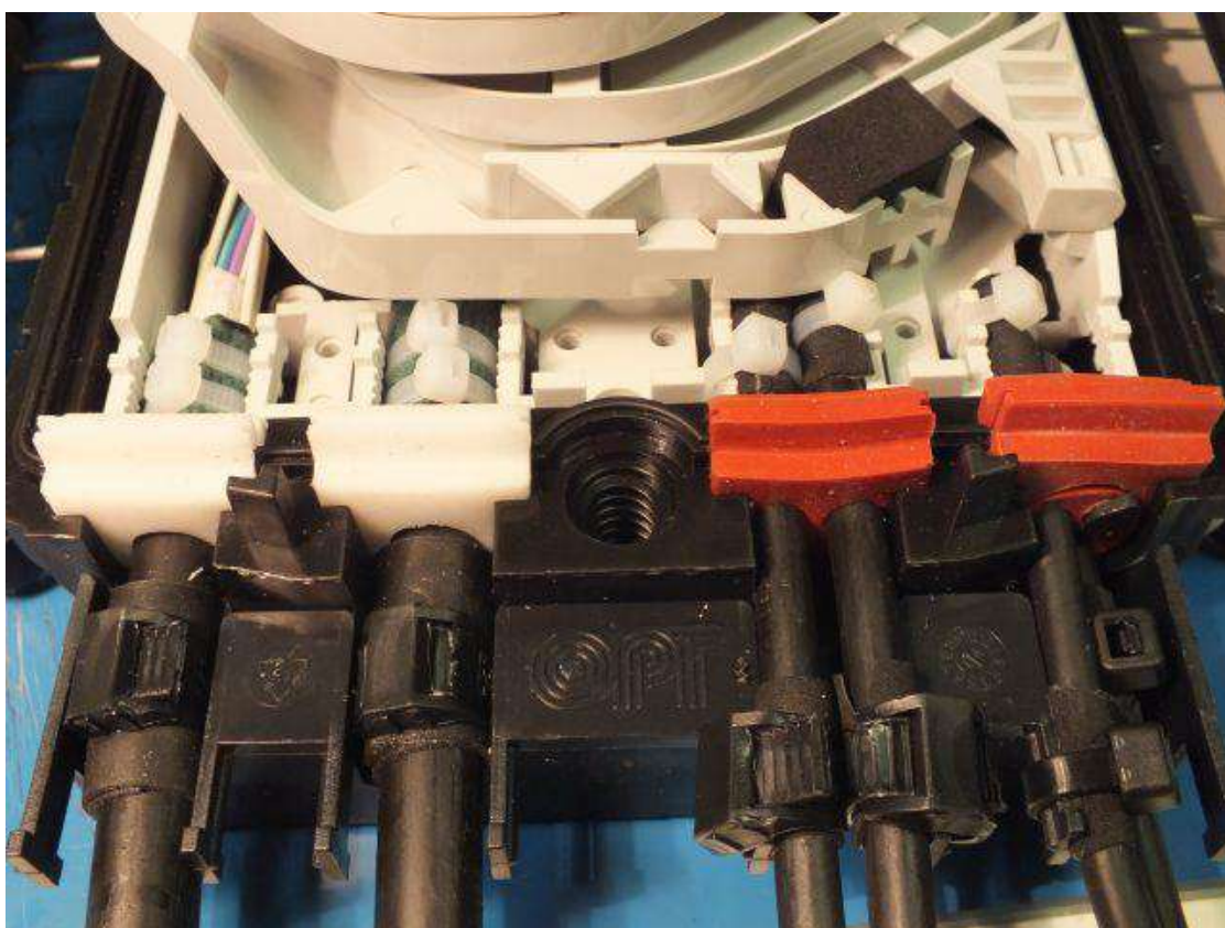
Mise en place des câbles avec étanchéité
